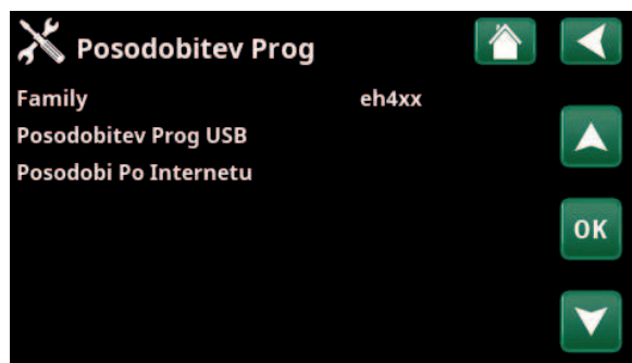
Meni: »Instalater/Servis/Posodobitev Prog«.
