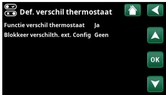
Menu: "Installateur/Definieer/Verskil thermostaat".
