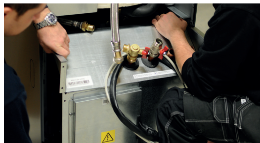
4. A kihúzásához előbb emelje meg kissé a hűtőmodult a hordozófogantyúkkal.
