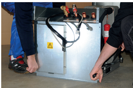
5. Emelje meg a hűtőmodult a hordozófogantyúkat és vállhevedereket használva.
