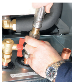
1. Kösse le a hűtőmodul tápkábelét és tömlőit.
