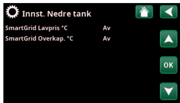
Meny «Avansert/Innstillinger/Nedre tank».
